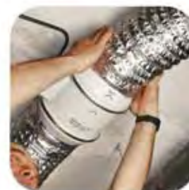
Montaż kanałów wentylacyjnych
